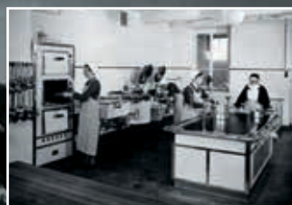
Instalación de cocción en Kloster 1960
